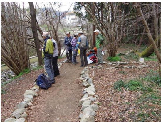
石積み直後の状況（2014年3月）
